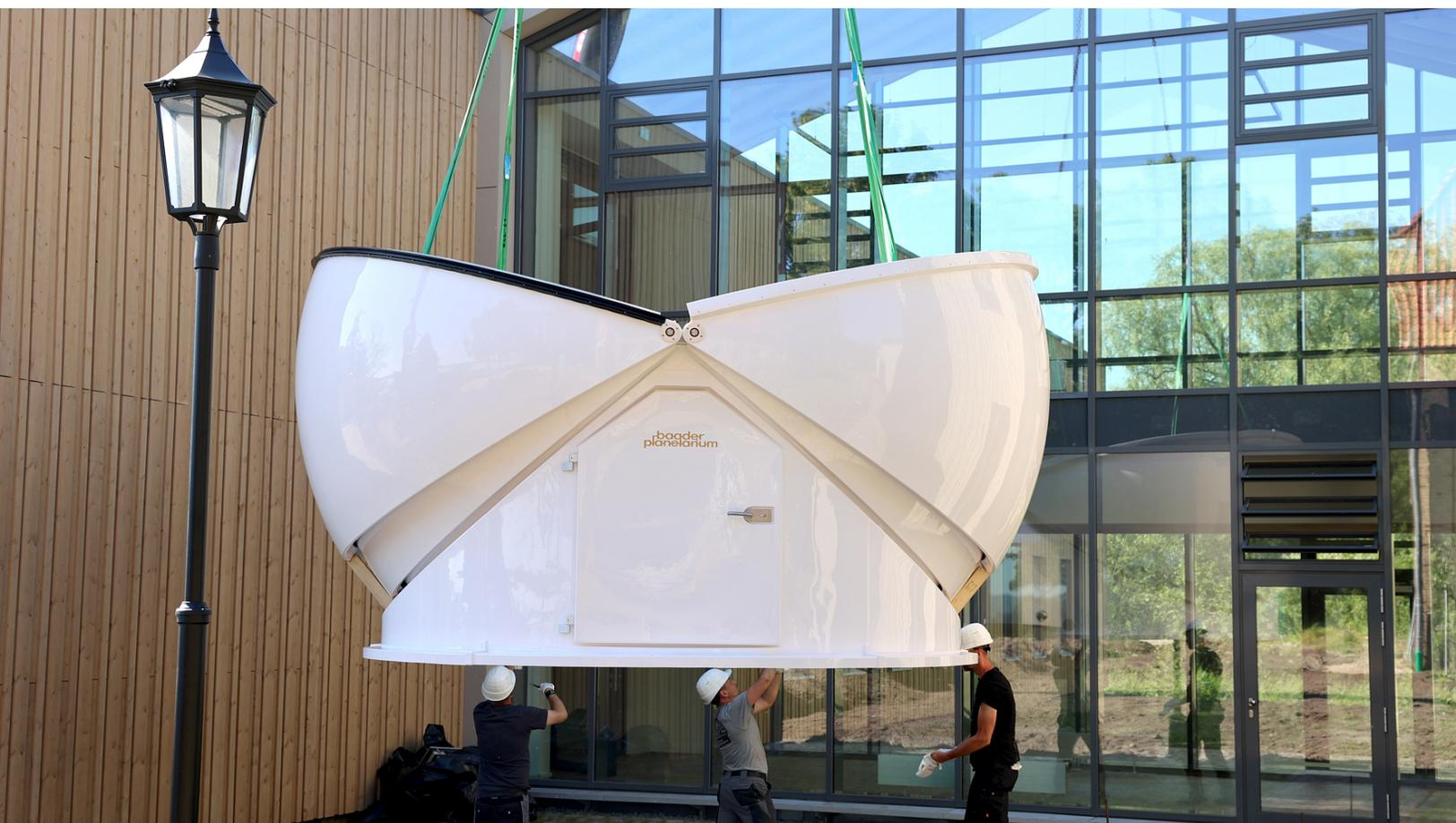
Nachdem die Kuppel auf dem Boden montiert wurde, hob der Kran sie in die Höhe.
